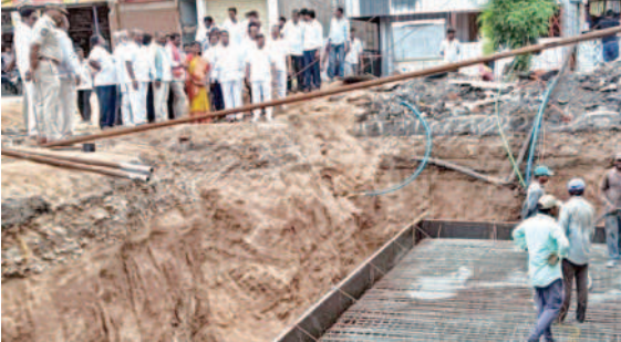
ఆర్‌ఓజీ పిల్లర్ పనులను పరిశీలిస్తున్న మాజీ ఎమ్మెల్యే సుధీర్‌రెడ్డి, చైరవర్చన్ పావని జంగయ్యయాదవ్
